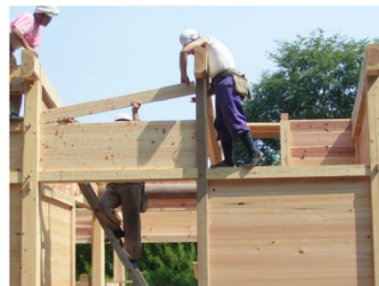
落とし込み板壁(左:施工状況、右:内部)
