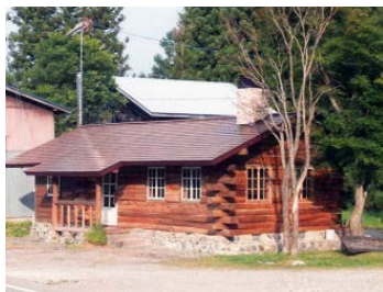
丸太組構法(外壁両側丸太組現し)
