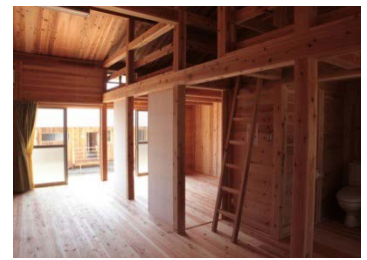
落とし込み板壁(左:施工状況、右:内部)
