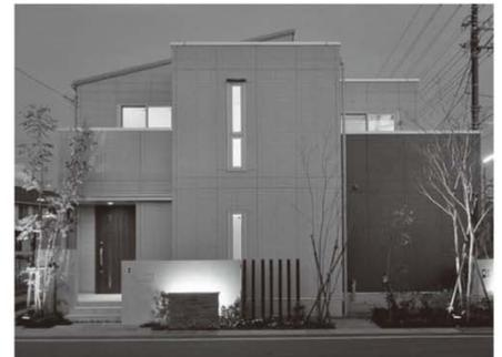
・屋外に設置された室外機を、木製ルーバーで囲い建物のデザインと調和させ、沿道景観へ配慮している。
