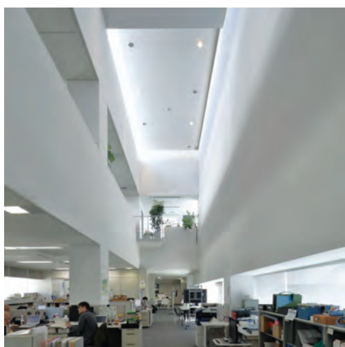
改修前：管理部門執務室
