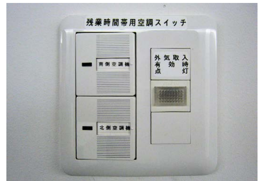
写真3.3-09-1：自然換気用パイロットランプ （大成札幌ビル）
