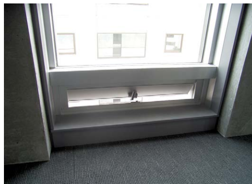
写真3.3-09-2：自然換気窓給気口の例（大成札幌ビル）
