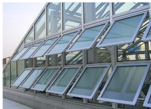
写真3.3-09-4：トップライトに設置された自動開閉窓（大成札幌ビル）
