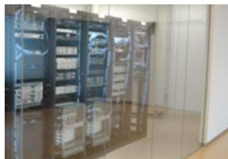
写真3.3-15-4：サーバーなど大きな電力容量に対応し、サーバーラックをガラス張りにして顧客に見せるスペースにする
