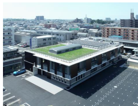
屋上太陽熱集熱設備 (2022.9月撮影)
